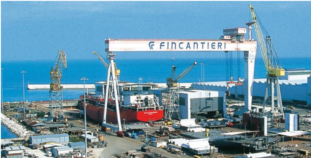
그림 10-1 | 대형군수지원함을 건조 중인 이탈리아의 핀칸티에리사
